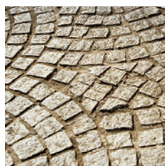
天然石舗装の目地
