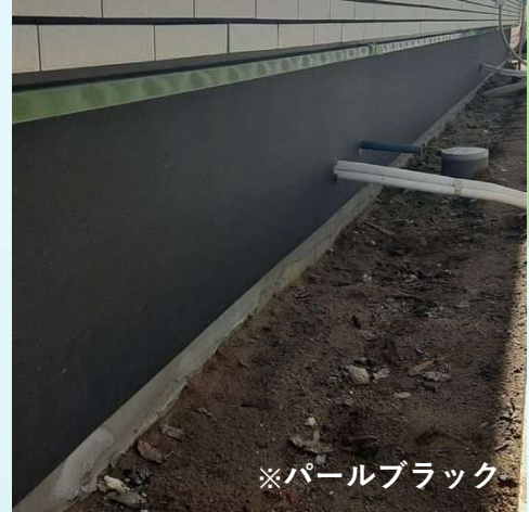
After (Fシート施工)
