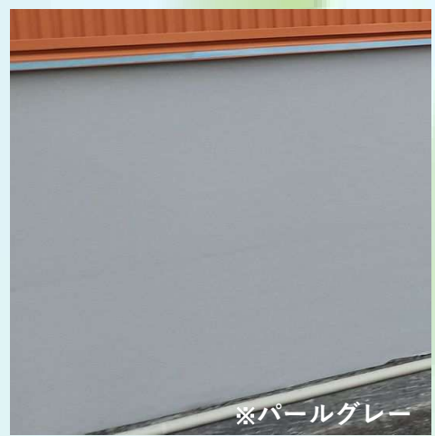
After (Fシート施工)
