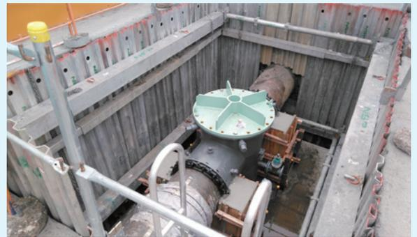
お客様からは、腹起しの段数が減り、作業スペースの確保や設置の手間が減り助かった。また、先に水圧四面梁を仮設置したおかげで、重量のある腹起しの設置が思ったほど大変ではなかった。そして、通常の腹起しよりも確実に段数を減らすことができるので、施工性が良い。ただ、4型腹起しが重いので、今回のように先に水圧四面梁で仮梁すると安定して設置ができる。とのお言葉を頂きました。
