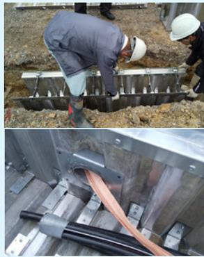
『NSP らくらくインフラBOX』は、そんな小型ボックス工法にご使用頂ける、リユースアルミ製の小型ボックスです。既存のコンクリート製の物と違ってアルミ製で、10分の1程度の重量しかありません。また、民地への引き込みも、従来の物よりもさらに簡単に行えるようになりました。
