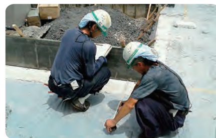
建築現場 (空調ヘルメット)
