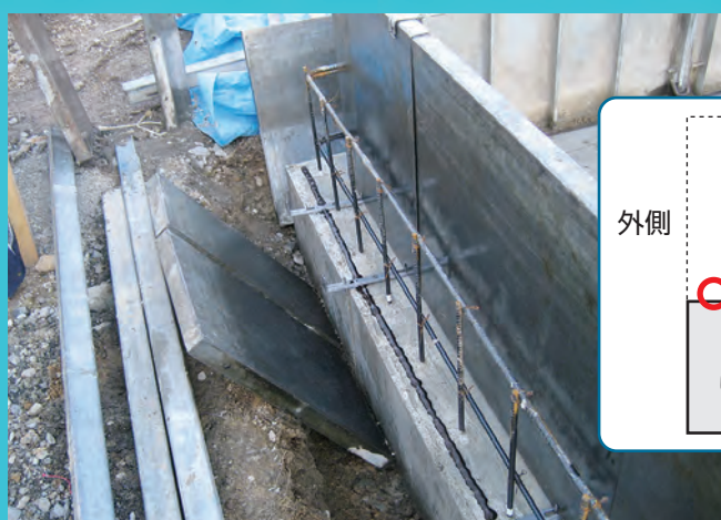
② 鉄筋の外側に塗布します。
