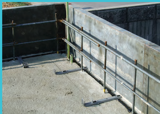
④ 巾止金具を載せたら、釘打ちして固定します。
