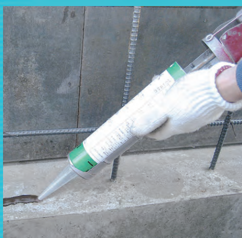
①ガンにセットして押し出すだけ。
