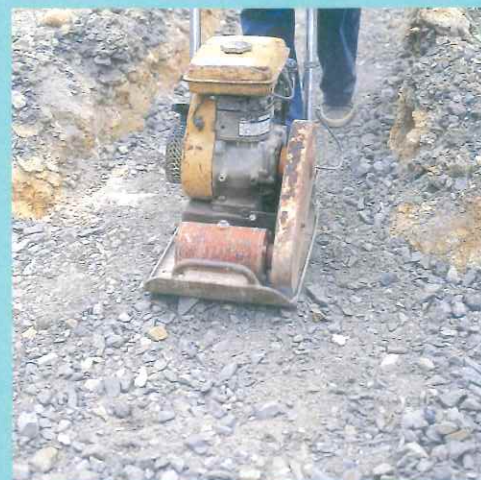
砕石を転圧し、レベルを出します。 (±10mm程度)
