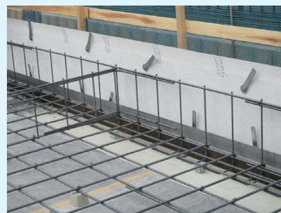
〈先張り施工〉 磁石と切欠きプレートでセットして固定します。
