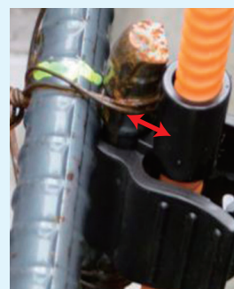
羽根軸が後方にずれたことで結束線が干渉しない。
