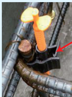
D13の縦筋に挟んでいる様子 (内側に13用ロック板あり)
