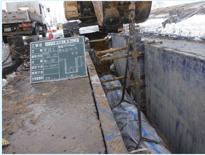
φ600×6m管敷設状況
