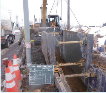
36パネル設置状況
