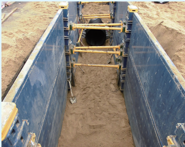
36パネル設置状況
