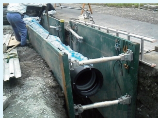
群馬県前橋市 送水管現場
