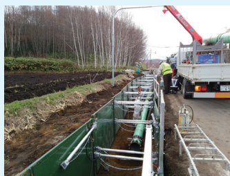
北海道網走市 導水管現場
