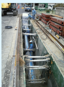
広島県福山市 配水管現場
