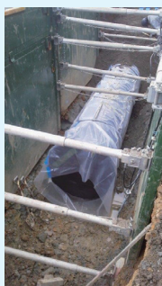
三重県津市 配水管現場
