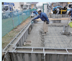
空調服を着用して基礎工事を行っている様子 宮城県:株式会社佐藤左官様
