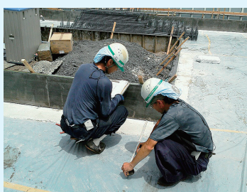
空調ヘルメットを着けて基礎工事を行っている様子 東京都世田谷区: (有)蔦徳様 施工現場
