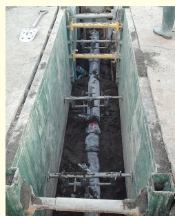
下水管入替え工事にてパイプサポート使用中
