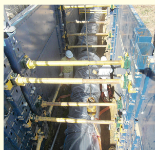
クイック土留36パネル 送水管敷設
